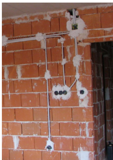
Kábelezés fa struktúrában
